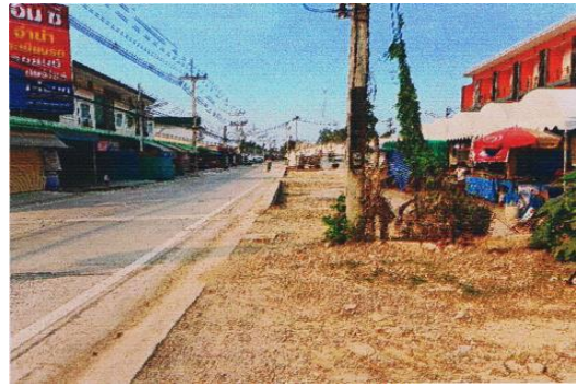
โครงการก่อสร้างท่อระบายน้ำ คสล. ต่อจากของเดิม บริเวณหน้าโครงการอำมาสี ไปจนถึงห้วยสมอ หมู่ ๔ ตำบลสระพัง
