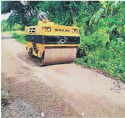
โครงการก่อสร้างถนนหินคลุกบดอัดแน่น ซอยบ้านนางอรุณ สว่างเลิศ (บ้านท่าหอย) หมู่ ๓ ตำบลทับคาง
