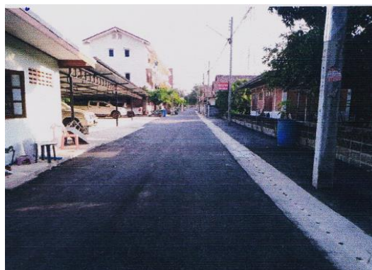
โครงการก่อสร้างปรับผิวจราจร เป็นแอสฟัลต์ติก คอนกรีต และก่อสร้างท่อเหลี่ยมระบายน้ำ คสล. ซอยปิ่นทอง หมู่ ๑ ตำบลเขาย้อย
