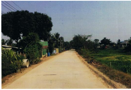
โครงการก่อสร้างถนน คสล. ฝั่งบ้านประธาน ชุมชนตลอดสาย พร้อมรองพื้นทางหินคลุกบดอัด แน่น (บ้านน้อยพัฒนา) หมู่ ๖ ตำบลเขาย้อย
