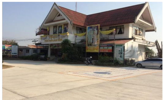
โครงการก่อสร้างปรับปรุงภูมิทัศน์ โดยรอบสำนักงานเทศบาล หมู่ ๕ ตำบลเขาย้อย
