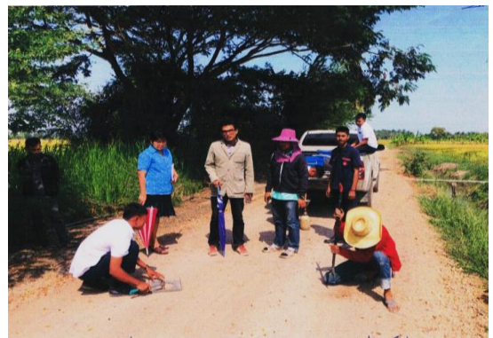
โครงการก่อสร้างถนนหินคลุกบดอัดแน่น ซอยทางลงนาหนองบัว หมู่ ๓ ตำบลบางเค็ม
