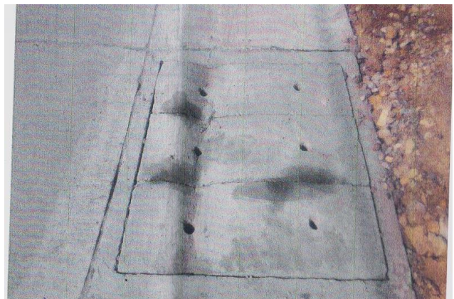
โครงการก่อสร้างท่อระบายน้ำ คสล. จากบ้าน นางรำไพ โลทอง ไปทางห้วยกระต่าย หมู่ ๒ ตำบลสระพัง
