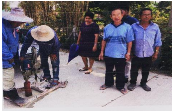
โครงการก่อสร้างถนน คสล. พร้อมท่อระบายน้ำ คสล. จากบ้านนายพูน แหล่งหล้า ถึงหลุมยืมคลองชลประทาน (บ้านหนองแห่นฝั่งล่าง) หมู่ ๒ ตำบลทับคา
