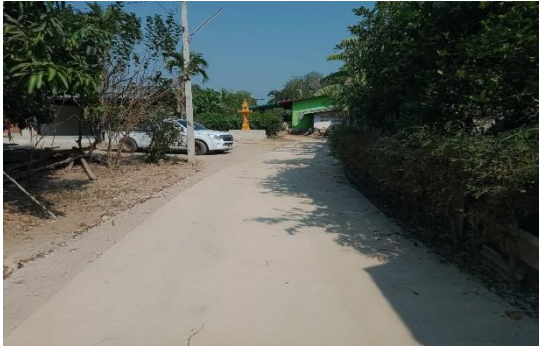
โครงการก่อสร้างถนน คสล. จากบ้านจำอาบ อินพุ่ม ถึง บ้านนางสาวสุชิน อินพุ่ม (บ้านห้วยแก้ว) หมู่ ๓ ตำบลเขาย้อย
