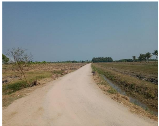
โครงการก่อสร้างถนนหินคลุกบดอัดแน่น จาก บ้านนายสมเกียรติ เชื่อมสถานีรถไฟ หมู่ ๖ ตำบลบางเค็ม
